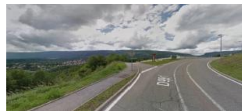
D991 – Grande Rue / Accès cimetière
