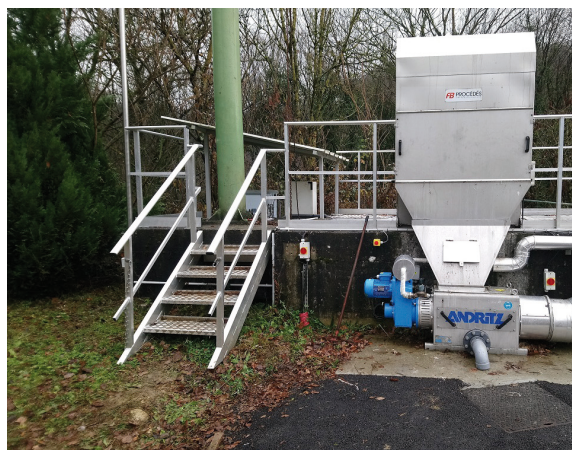
Renouvellement de la pompe de refoulement et mise en place d'un dégrilleur grossier en entrée de station avec compactage des déchets.
