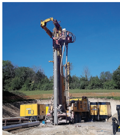
Réalisation de l'avant-trou du futur forage « Puit de Chaix ».
