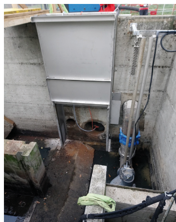
Renouvellement de la pompe de refoulement et mise en place d'un dégrilleur grossier en entrée de station avec compactage des déchets.
