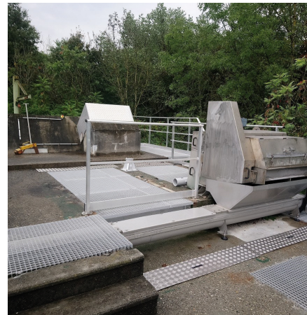
Renouvellement de la pompe de refoulement et mise en place d'un dégrilleur grossier en entrée de station avec compactage des déchets.
