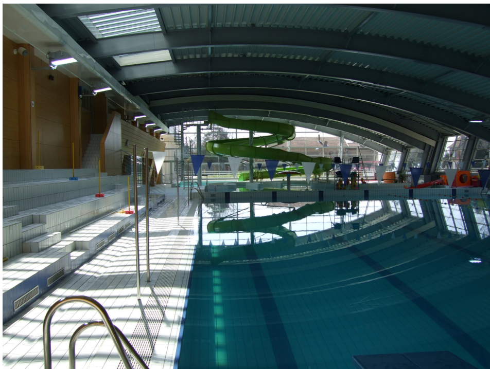
Vue générale d'un bassin intérieur d'une piscine
