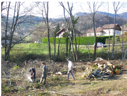
Chantier de la future MARPA à Champfromier
