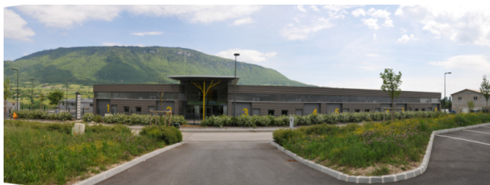
Vue générale de la pépinière d'entreprises des Etournelles à Châtillon-en-Michaille
