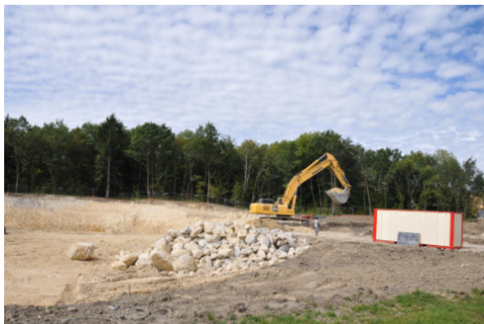
Vue générale de la construction du centre aquatique
