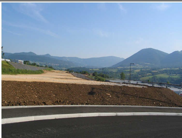
L'extension de la zone des Etournelles à construire
