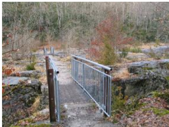
Rambardes de sécurité au Pont des Oules
