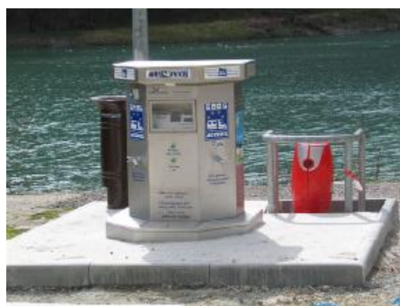
Borne installée avant la pose de l'enrobé – 13 mars 2008
