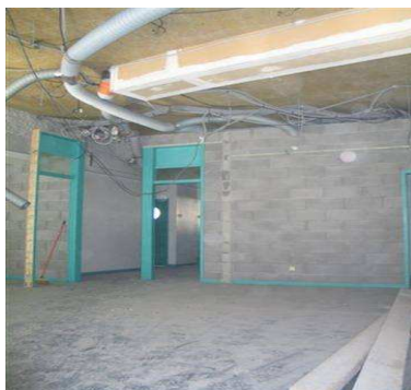
Plateau de la MEEF en travaux
