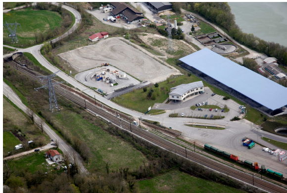
Déchetterie de Bellegarde (à gauche), près du SIDEFAGE à Arlod
