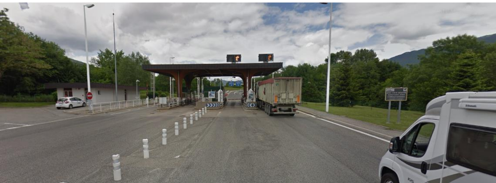
Le péage autoroutier ne permet pas de voir le secteur caché derrière la végétation.
