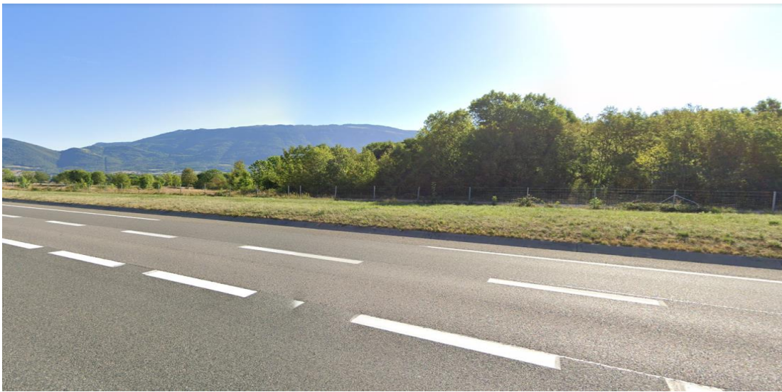
Vue de l'autoroute sur le secteur de l'étude. La végétation offre une paysage fermé sur le site.
