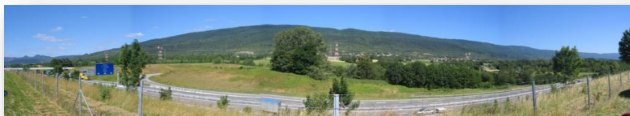
- Vue générale du site à hauteur des bretelles d'accès à l'A40 -
