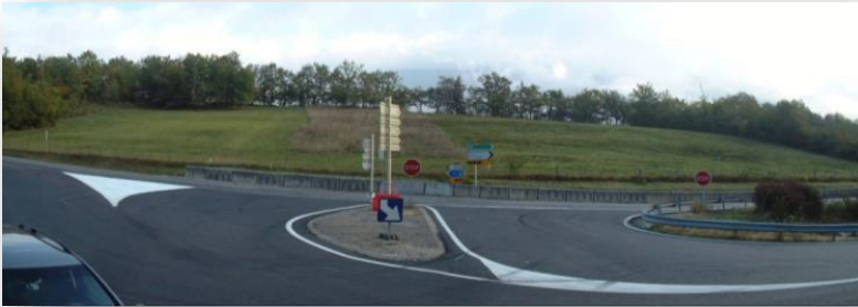
- Une rupture de pente au Sud -
