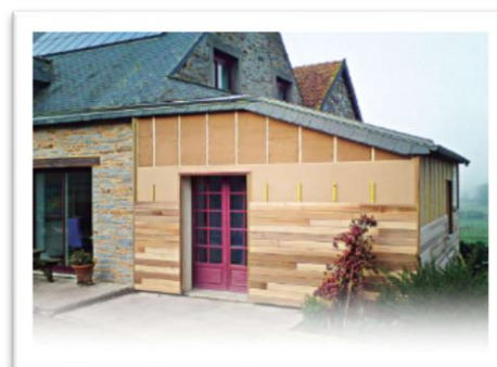
Figure 87: photo d'une maison en rénovation
