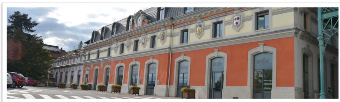
Figure 176: Photo de la Passerelle des arts à Valserhône Crédit photo : Commune de Valserhône
