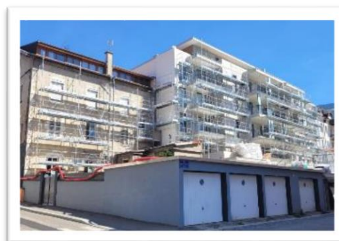
Figure 60: photo d'un bâtiment en construction Crédit photo : Commune de Valserhône - Anaïs Wanwestwinkel
