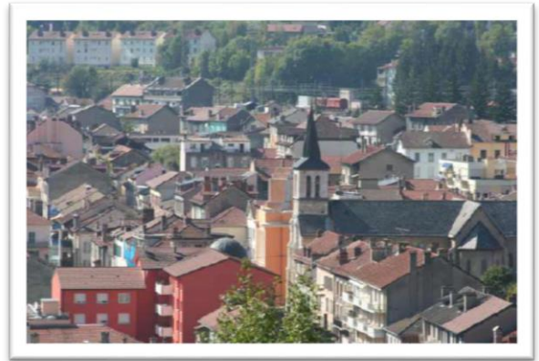
Figure 132: Photo de l'urbanisation du centre-ville de Bellegarde
