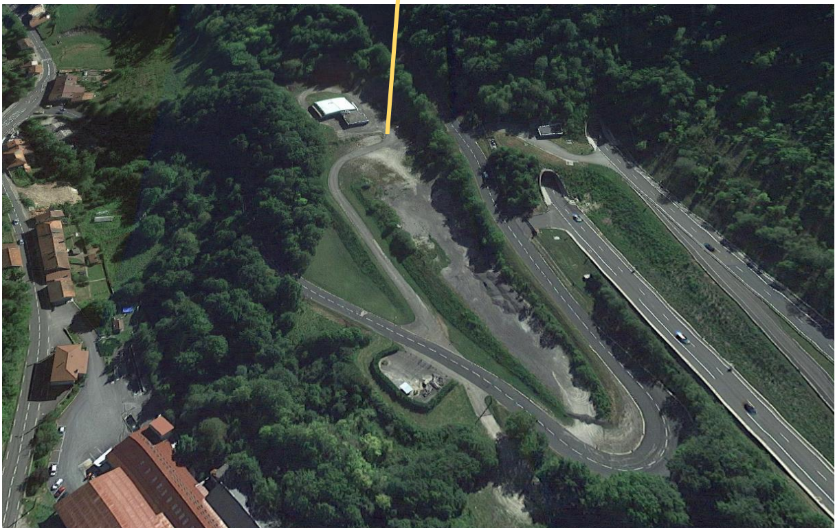
Vue aérienne de la zone d'activités des ENVERSIERS
